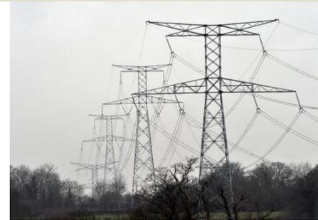
° La chaînette est d'une importance capitale car elle permet de calculer les *flèches* (c'est-à-dire la distance de l'arc à de corde) à donner aux câbles suspendus afin que les tensions aux points d'accroche ne soient pas excessives (comme à gauche sur des pylônes EDF). En effet, dès que l'on cherche à tendre par trop un câble entre deux pylônes, les tensions deviennent considérables.
